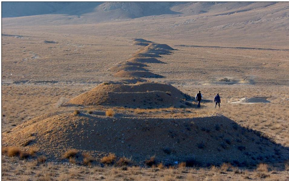
Fig. 1 – Allineamento di pozzi lungo il *qanat* esteso tra Mojen e Shahrud, Iran.
