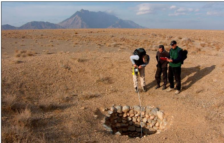
Fig. 4 – Rilievi del *qanat* di Bear Jomand, Iran. Misurazione della quota e della profondità di un pozzo.
