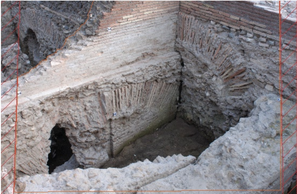
Fig. 7 – Ripresa fotogrammetrica dell'angolo S-E dell'ambiente 7 delle "Terme di Elagabalo", caratterizzato da forti differenze altimetriche.
