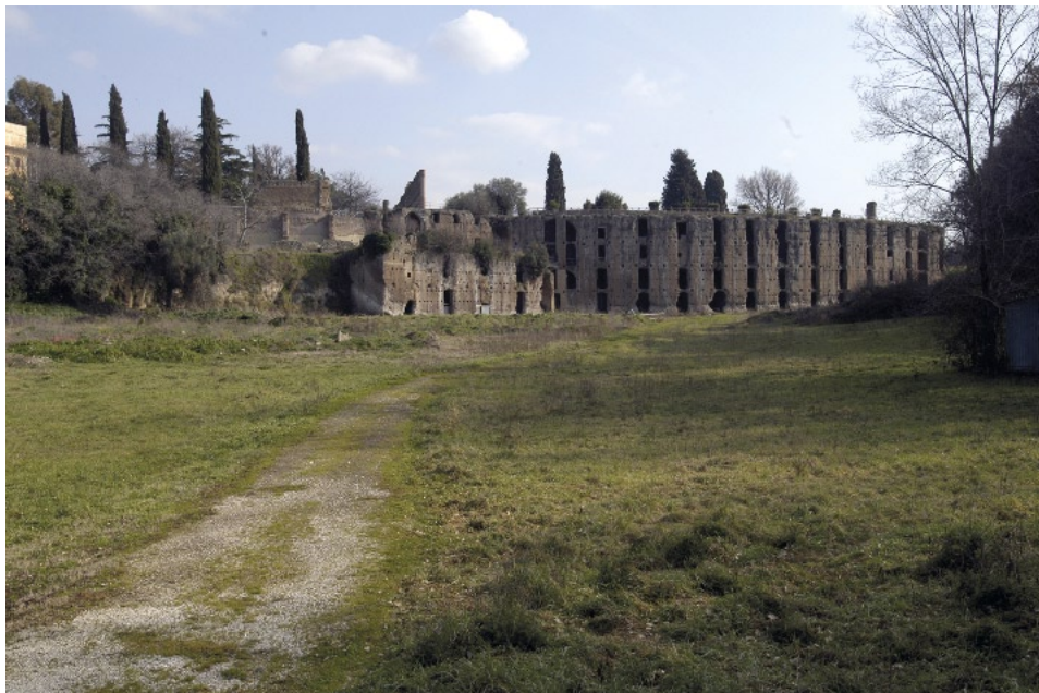
Fig. 3 – Immagine del terrazzamento su cui è costruito il Pecile e il cui muro di sostegno è realizzato con un complesso di camere note come Cento Camerelle.
