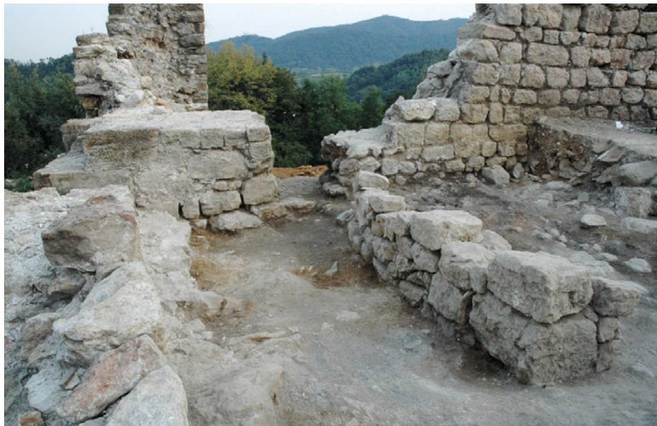
Fig. 7 – Particolare del settore I: a destra la postazione militare e di fronte il taglio realizzato nel perimetrale nord della torre (foto M. Frassine).
