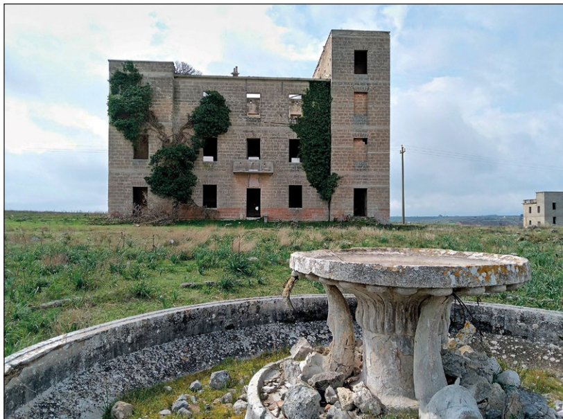
Fig. 1 – L'edificio di comando del campo 65 (ottobre 2019) (G. De Felice).
