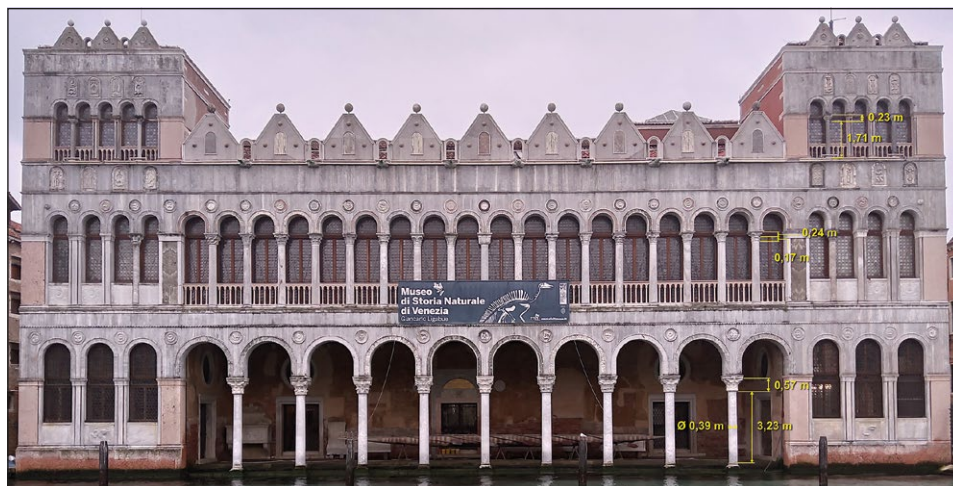
Fig. 3 – Processo di misurazione a campione di alcuni capitelli e colonne di età romana, medievale e ottocentesca in opera nel portico di riva, nel loggiato e nella torretta laterale destra del cosiddetto “Fondaco dei Turchi”, Canal Grande, Venezia (E. Delpozzo, M. Pilutti Namer).
