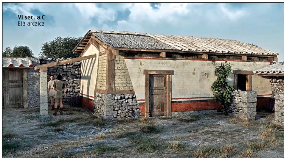
Fig. 9 – Particolare della tecnica costruttiva in mattoni crudi e spiccato in pietra a secco.
