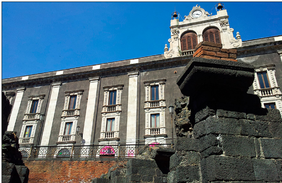
Fig. 1 – Catania, Anfiteatro. Esempio di stratificazione architettonica complessa. Le strutture romane dell'anfiteatro sovrastate dal monumentale Palazzo Tezzano (1709).
