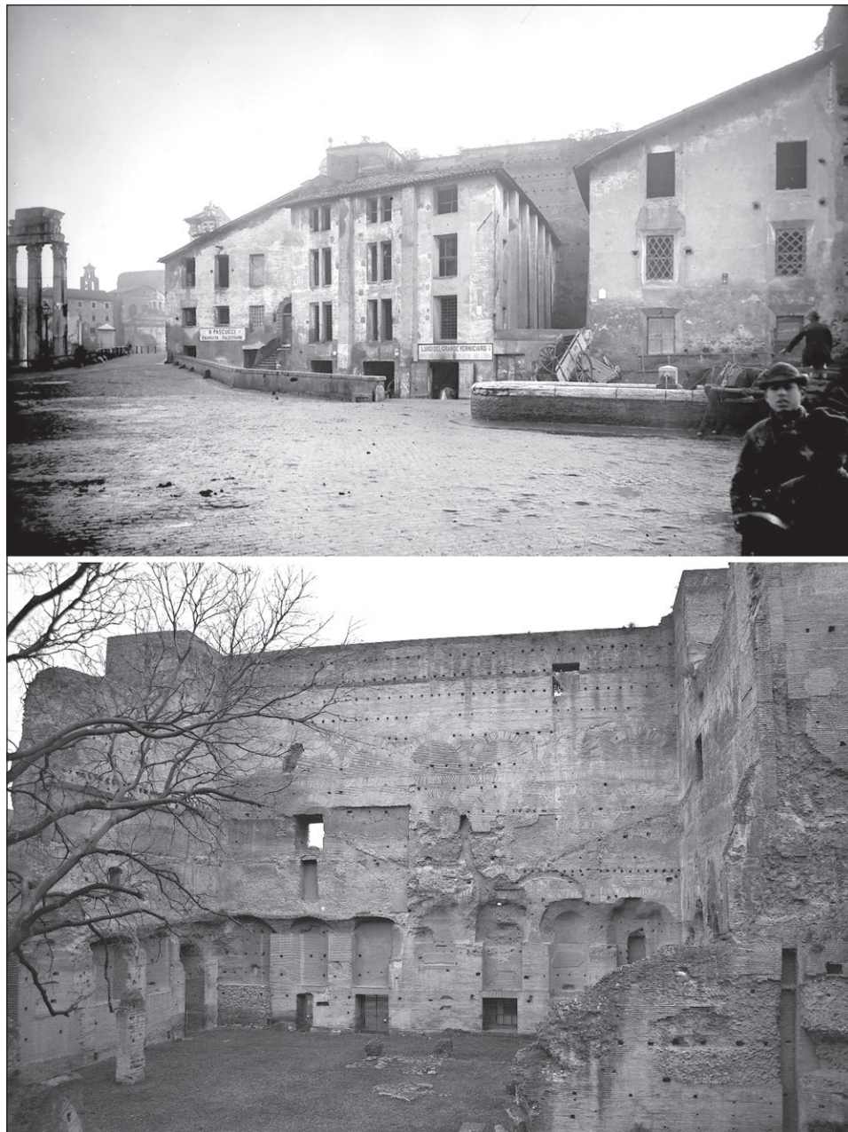
Fig. 1 – Roma, Foro Romano-Palatino, Aula Ovest, prima delle demolizioni, anno 1885 (in alto) e dopo le demolizioni, anno 2020 (in basso) (SANFILIPPO 1992, 50; DEL PRETE 2002, figg. 4-5).
