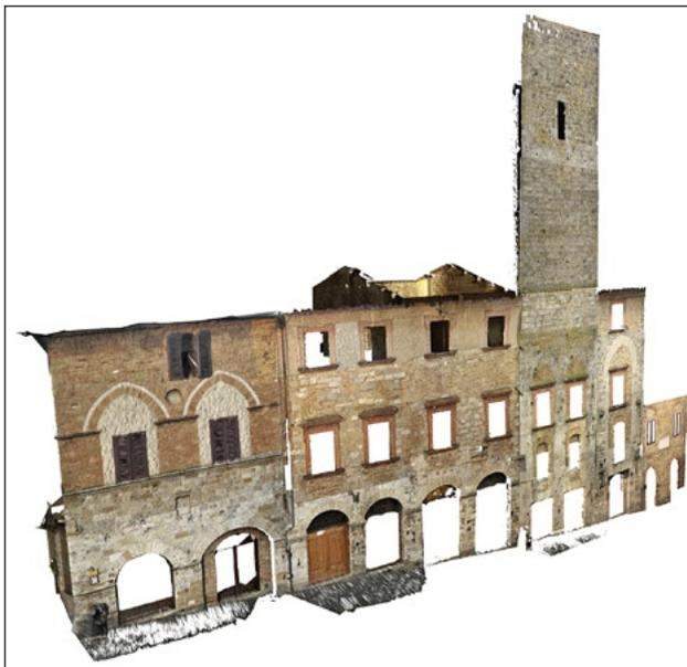
Fig. 2 – Modello 3D in nuvola di punti RGB di Palazzo e Torre Campatelli.
