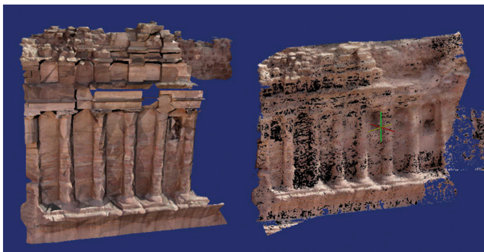
Tav. X – a: Petra. Il dilavamento dell'acqua lungo le superfici rocciose rappresenta una causa evidente del degrado delle facciate architettoniche (GABRIELLI et al. , p. 323). b: Petra. Tomba Palazzo. Immagine relativa al momento di acquisizione dei dati: il pallone sorvola la parte alta del monumento più difficile da riprendere. Per assicurare una copertura completa dell'edificio ogni 2 secondi è stato effettuato uno scatto (GABRIELLI et al. , p. 336). c: Petra. Tomba Palazzo. Il modello tridimensionale superiore è stato ottenuto attraverso la correlazione manuale dei punti e delle superfici (3500 punti) con Photomodeler 6.0. Il modello ottenuto elaborato opportunamente con ARPENTEUR e ROMA dà origine ad una nuvola di punti molto più fitta rispetto a quella iniziale (modello inferiore) (GABRIELLI et al. , p. 338).
