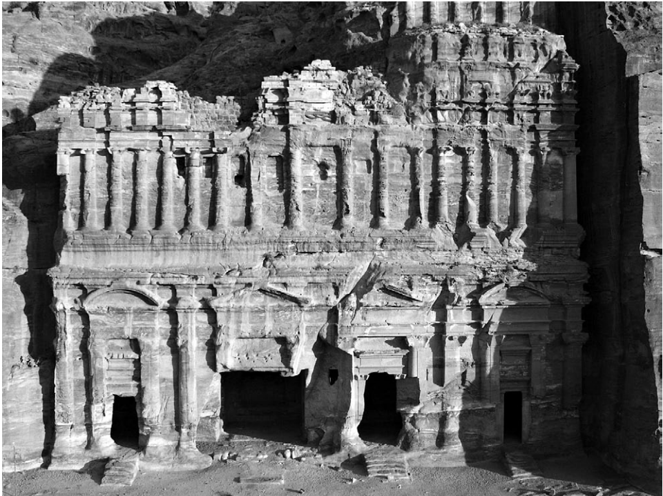
Fig. 10 – Foto aerea da pallone aerostatico frenato di tutta la fronte attualmente visibile della Tomba Palazzo; si noti la differenza costruttiva tra la parte alta e bassa dell'edificio e del processo di degrado scatenato dal dilavamento delle acque sulla superficie architettonica.
