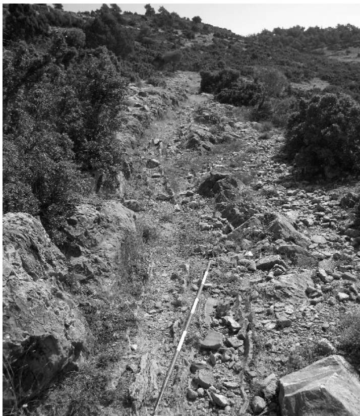
Fig. 13 – Tratto di acquedotto con due tubature affiancate ed alloggiate in un incasso scavato nel banco roccioso.
