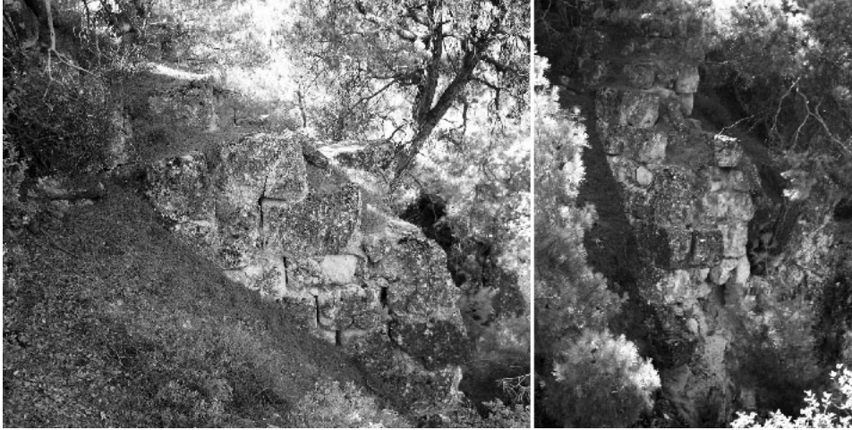
Fig. 9 – Due vedute della spalla meridionale del ponte a blocchi lungo il Gök Dere.
