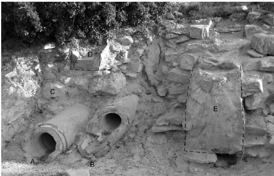
Fig. 12 – Due tubi affiancati (A, B) che ne obliterano un terzo (C), messi in luce da uno sbancamento. In alto (D) ed a destra (E) si notano i resti di due canali completamente riempiti da incrostazioni di calcare: il secondo, in particolare, presenta spallette in muratura (in blocchetti e pietrame legato da malta), rivestite di intonaco idraulico, ed il fondo costituito da grandi tegole di terracotta.
