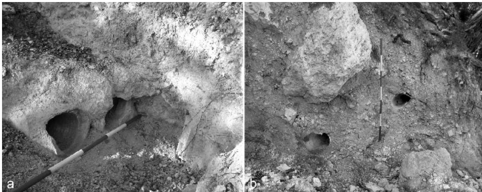
Fig. 10 – Due sezioni artificiali che hanno messo in luce i tubi dell'acquedotto a NE di Hierapolis.
