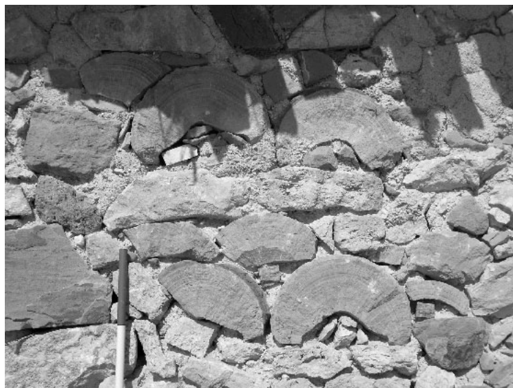
Fig. 14 – Frammenti di tubi con concrezioni di calcare riutilizzati nelle murature di un edificio rurale.
