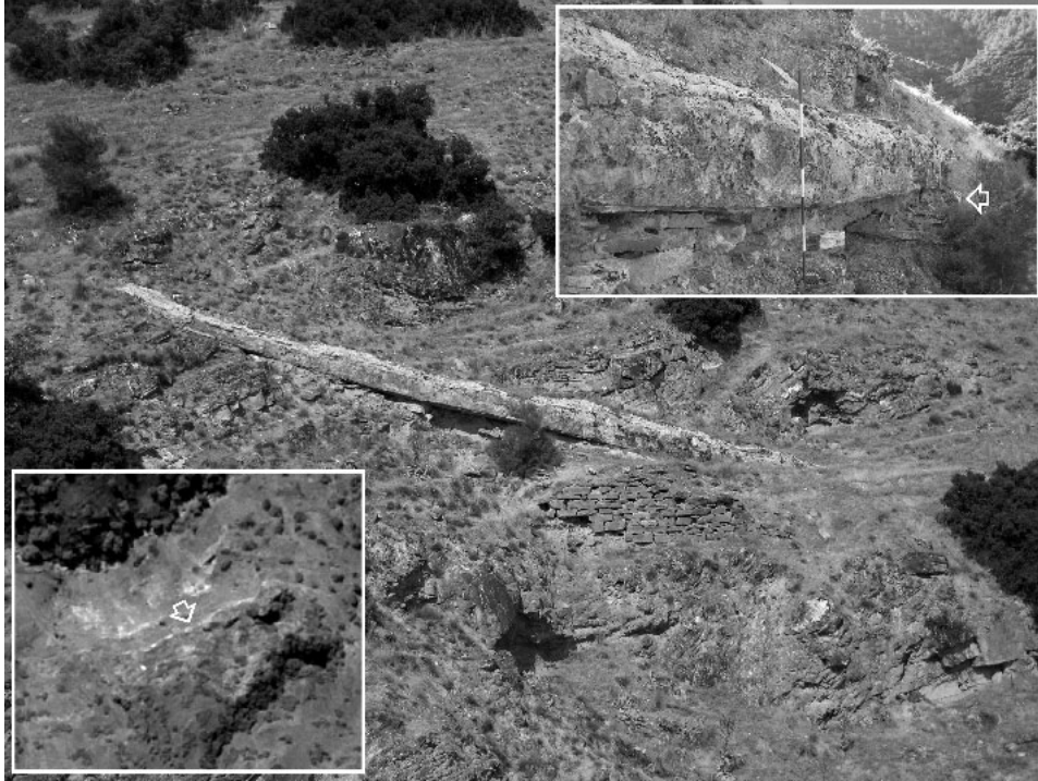
Fig. 15 – Tratto di canale pieno di concrezioni calcaree. Nel riquadro in alto, è visibile un particolare della struttura, che era delimitata da spallette in muratura e di cui è ancora conservato il fondo a grandi tegole; la freccia indica uno dei tubi in terracotta a fianco del canale. Nel riquadro in basso, invece, compare la traccia dei resti del canale nell'immagine satellitare.
