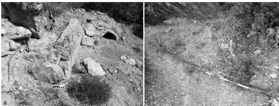
Fig. 16 – A sinistra, tubo in terracotta e canale in muratura pieno di concrezioni calcaree messi in luce da uno sbancamento; a destra, tratto di condotta alle pendici settentrionali del Tingirtaş Tepe.
